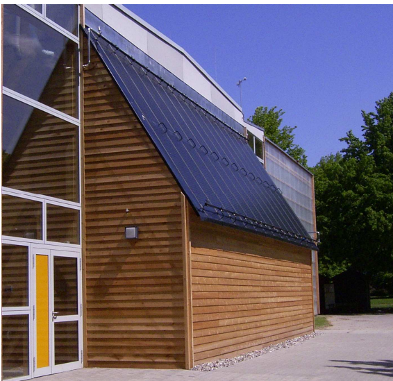
Abbildung 1: Solardach AS von Energie Solaire an der KITA Sonnenschein in Wismar
